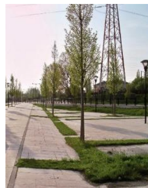
Tranchée drainante au bord de la RD28 en Seine-Saint-Denis (source : Composante Urbaine)
